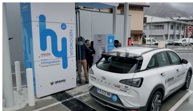
Tankstelle für Wasserstoffautos in Moûtiers (Frankreich).
